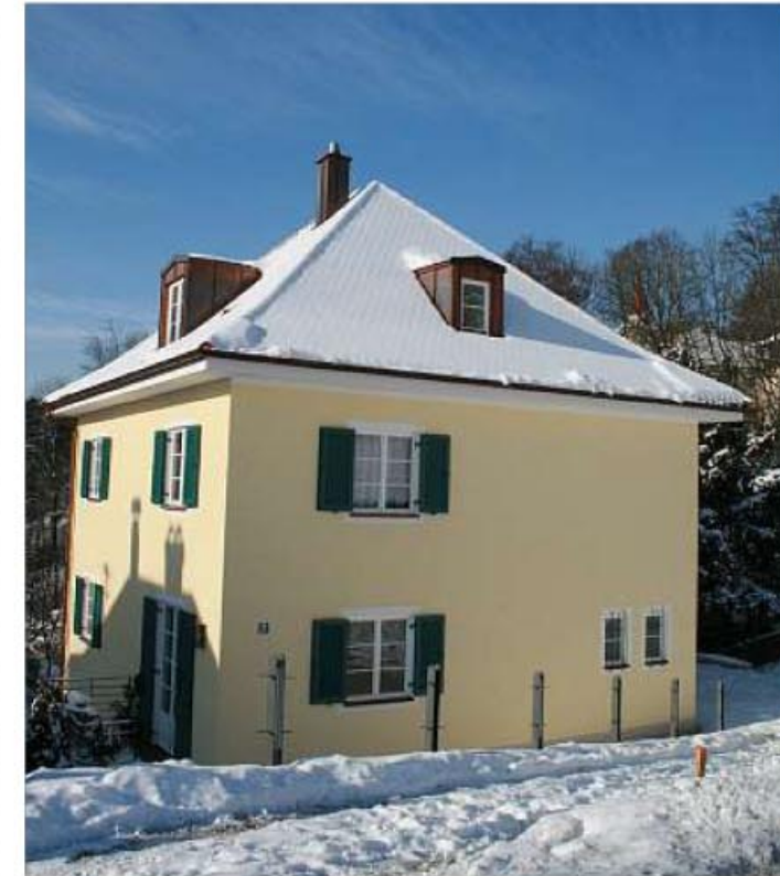
Der Bau von Einfamilienhäusern (wie hier in Passau-Ries), individuell auf die Wünsche und Anforderungen der Auftraggeber abgestimmt, sind von jeher eine der Stärken der Schneider-Bau GmbH.
