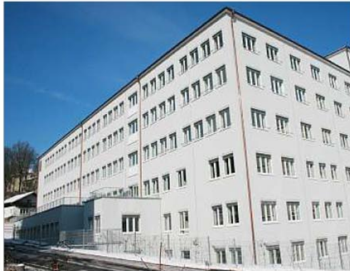
Das bisher größte Projekt, welches Schneider-Bau realisierte: Der vierte Bauabschnitt des Klinikums Passau.
