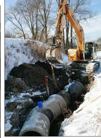
Selbst bei Außentemperaturen von -20 Grad sind die Mitarbeiter von Schneider-Bau im Arbeitseinsatz.
