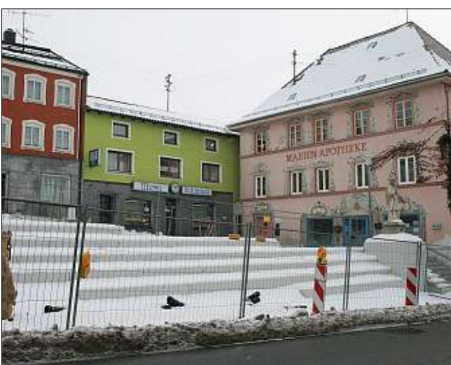
Tiefbaumaßnahmen in Tittlings „guter Stube“ – der Marktplatz wird von der Schneider Bau GmbH saniert, Fertigstellung ist im Sommer.
